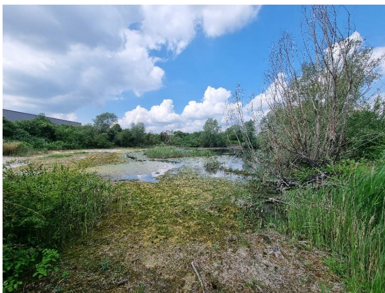
Abbildung 6: Blick in westlicher Richtung in das asphaltierte, ehemalige Klärschlammbecken (OSS).
