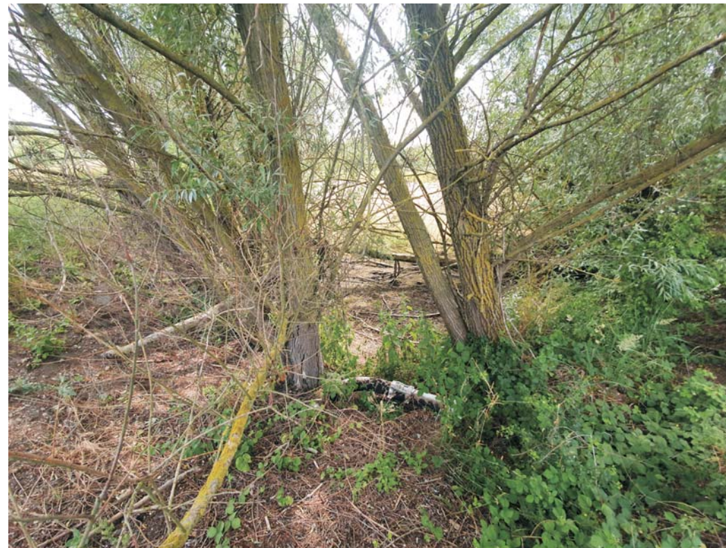
Altes Zu-/Ablaufrohr am Nordende des Beckens
