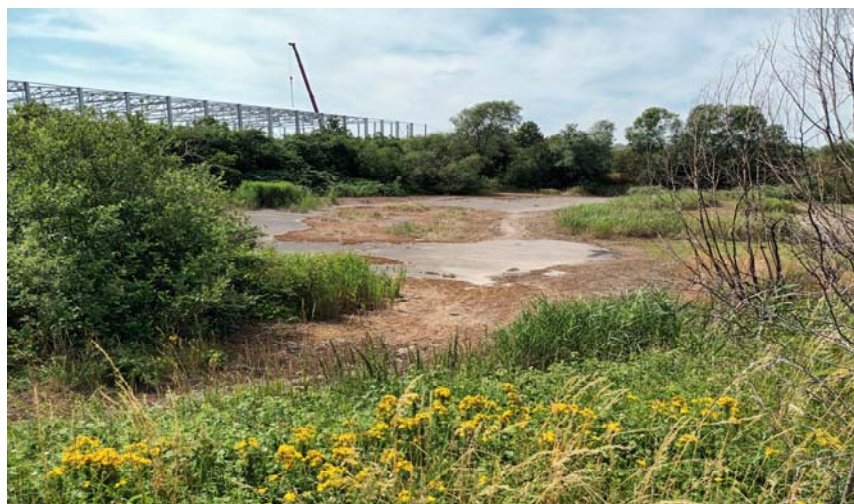
Blick von Nordosten auf das Klärbecken, im Hintergrund die in Erweiterung befindliche Gewerbefläche
