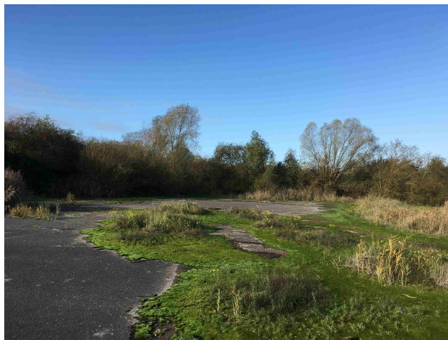
Foto: Aufnahme vom 12.12.2019 in das Becken B hinein. Blick Richtung Norden
